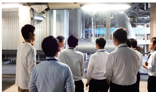
工場見学の様子。 発電所の現場を初めて見学した受講者も。
