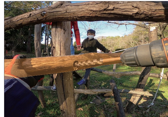
03 つける 部材をボルト接合する
